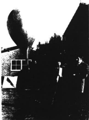
Medewerkers van het KNMI laten een weerballon op. Eén man heeft de zender vast. Het vierkante ding is de radarreflector om de ballon met radar te kunnen volgen
