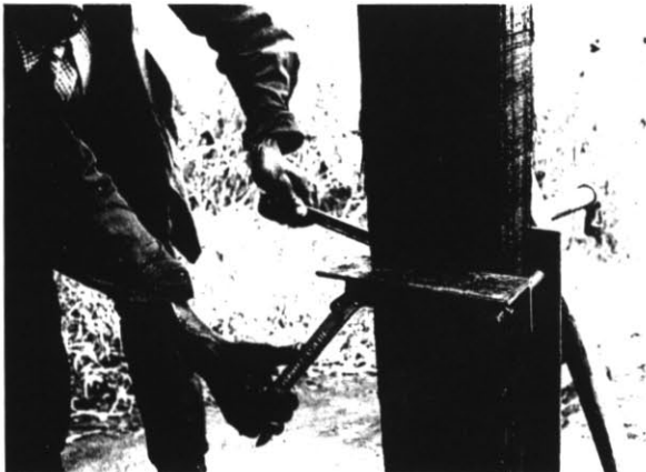
Na enige tijd moeten de moeren weer worden vastgedraaid
