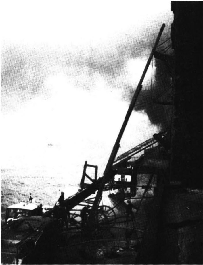
Het blussen van een brand in een warehouse langs de Thames in Londen.
