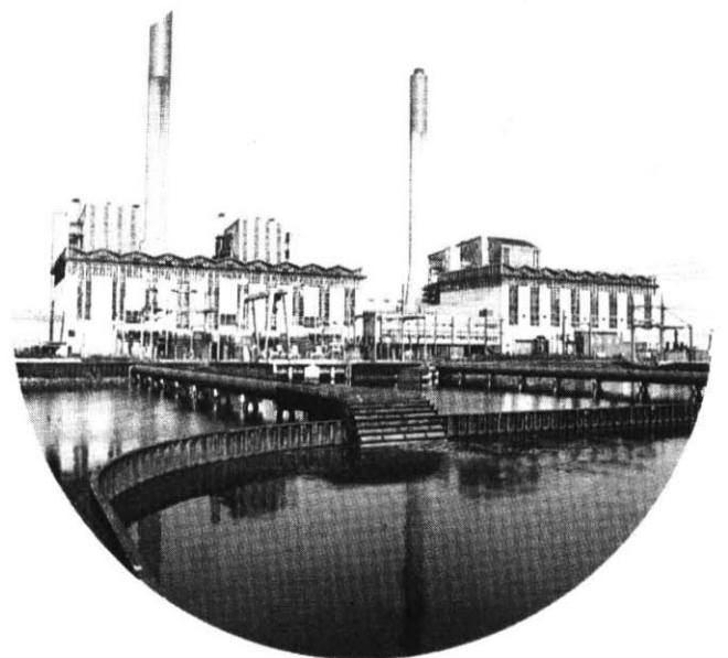
Koelwaterbassin voor het afvoeren van de overtollige warmte bij een electriciteitscentrale.
