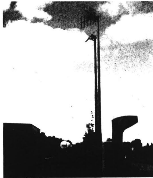
Langs de snelweg Utrecht-Den Haag staat ter hoogte van Nootdorp een ANWB-praatpaal die van energie wordt voorzien door een paneel met zonnecellen. Het paneel bevindt zich op de achterste mast
