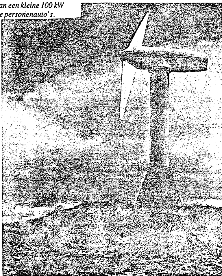
Fig. 10.2 De 25 m diameter windturbine op het ECN-terrein te Petten. Het maximale vermogen bedraagt 300 kW, het gemiddelde vermogen ca. 100 kW. (Foto ECN).
