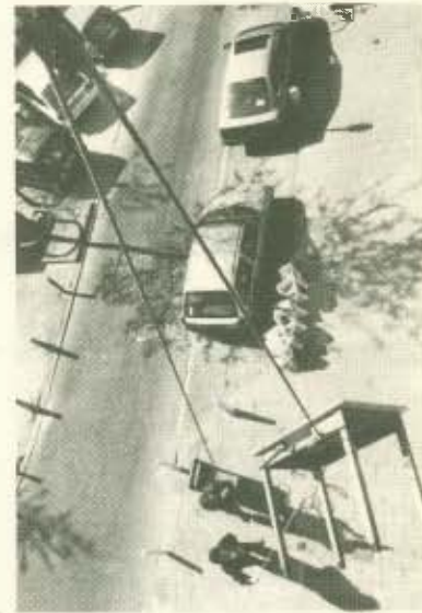
fig. 25 Een voorwerp ophijzen met een katrol.
