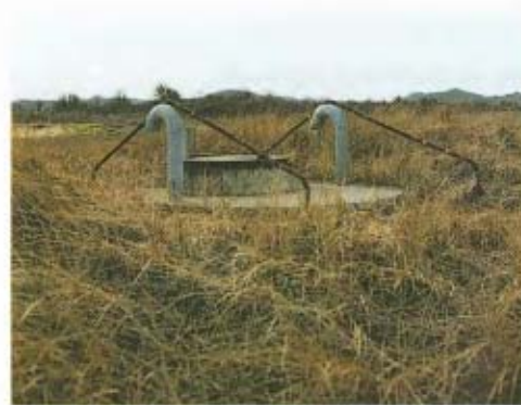
FIG. 18 Een put voor diepinfiltratie in Noord-Holland.
