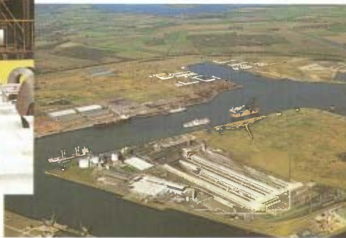
FIG. 28 De aluminiumfabriek van Pechiney bij Vlissingen.
