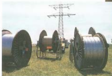
FIG. 56 Hoogspanningsleidingen van aluminium.
