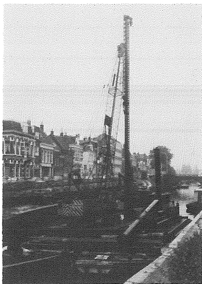
Fig. 4 Het slaan van heipalen.
