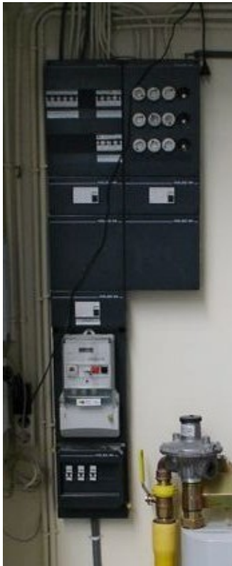
Figuur 1.32: Meterkast met kWh-meter, hoofdschakelaar, aardlekschakelaar en groepszekeringen.
