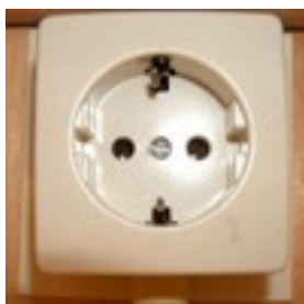
Figuur 1.35: Stopcontact met randaarde.
