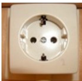
Figuur 1.35: stopcontact met randaarde.
